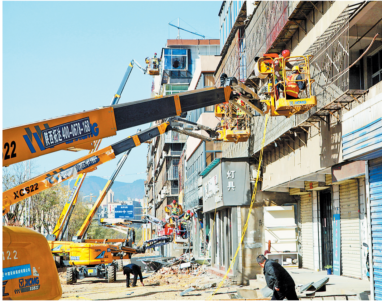
连日来，山阳县“两拆一提升”工作的拆除工程施工队持续在县城滨河北路拆除违法建筑以及妨碍公共安全的违法建设，努力消除城市安全隐患，提升城市品质。（王荣金 摄）
