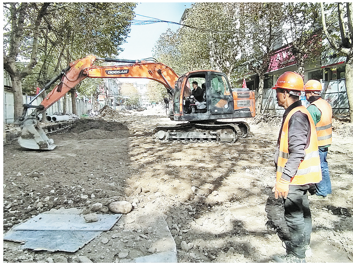
11月12日,在洛南县西街,施工队正在用挖掘机进行路面改造。该县老城区改造工程经过一年多建设,目前地下管网已铺设完毕,进入地上工程施工阶段。(记者 贾书章 摄)
