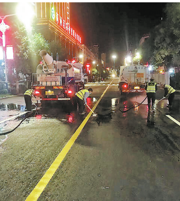
市中心城区道路(名人街、中心街)提升改造项目路面施工历时45天全面完成,于11月11日全路段开放交通。本次改造将破损水泥路面改造为沥青路面,减少行车噪音和道路扬尘污染的同时也极大提升了行车安全性。(拓宏强 摄)
