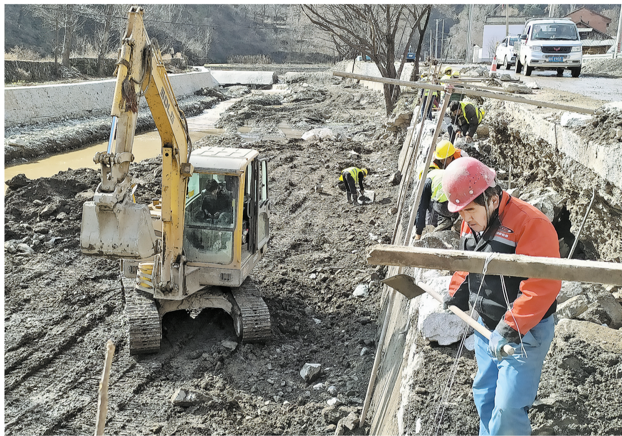
11月16日,商州区三岔河镇灾后重建工程正在进行路堤结合工程施工。据工程建设项目部介绍,目前已完成总工程的70%,工程建成后,河道行洪更加通畅,将大大提高路堤防洪抗灾能力。(记者 贾书章 摄)
