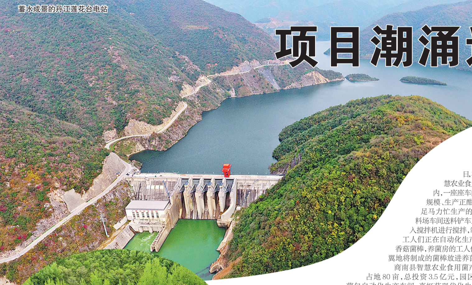
晋办成景的河江莲花台电站
