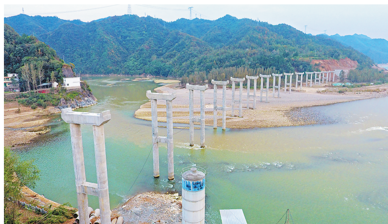
G345国道丹江桥梁建设现场
