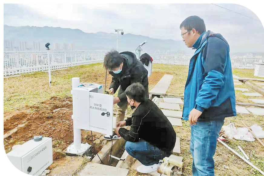
11月26日，市气象局完成了丹凤县国家观测站冻土自动观测仪的安装建设。冻土自动观测仪实现了对冻土要素24小时全天候全自动观测，对提高冻土观测准确性和一致性，提升全市地面气象观测系统自动化程度有着重要作用。市气象局将陆续完成其他县区冻土自动观测仪的安装，实现冻土自动观测全市全覆盖。（刘莉摄）
