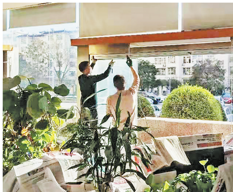
近日，商洛公路管理局勘察设计院对办公区域进行安全隐患大排查，为职工营造良好的工作环境。图为维修师傅正在清理破损门窗。（刘锋波 摄）
