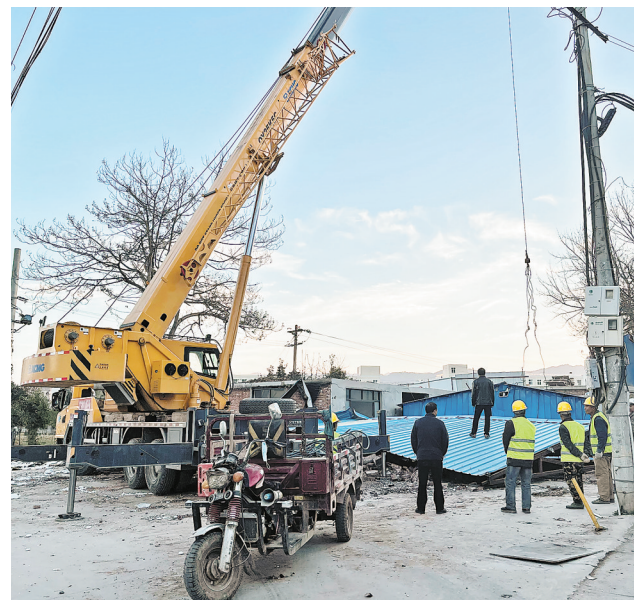
近日,商州区城管局城管综合执法大队联合陈堰街办仙娥湖社区,对仙娥湖社区二组的1000平方米违建建筑进行了拆除。(记者 方方 摄)
