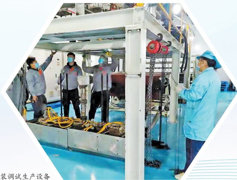
安装调试生产设备
