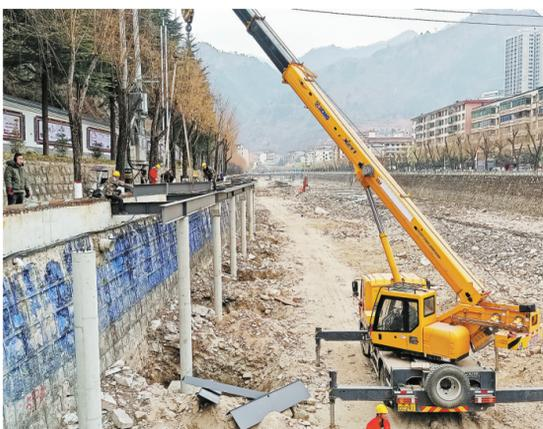
12月10日,在柞水县乾佑河旁,工人正在紧锣密鼓地进行城区休闲健身步道建设。该工程是2021年县城基础设施建设提升重点工程,采取悬架结构形式,总长3248.09米,建成后河西居民居住环境将明显改善,出行拥堵问题会得到有效缓解。(詹涛涛 摄)
