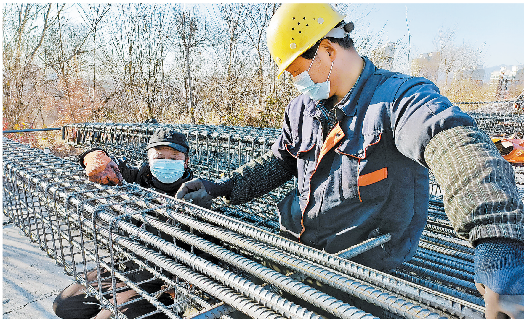
洛南县面对严峻疫情形势,一手紧抓疫情防控,一手抢抓项目建设。(柯玉栋 摄)
