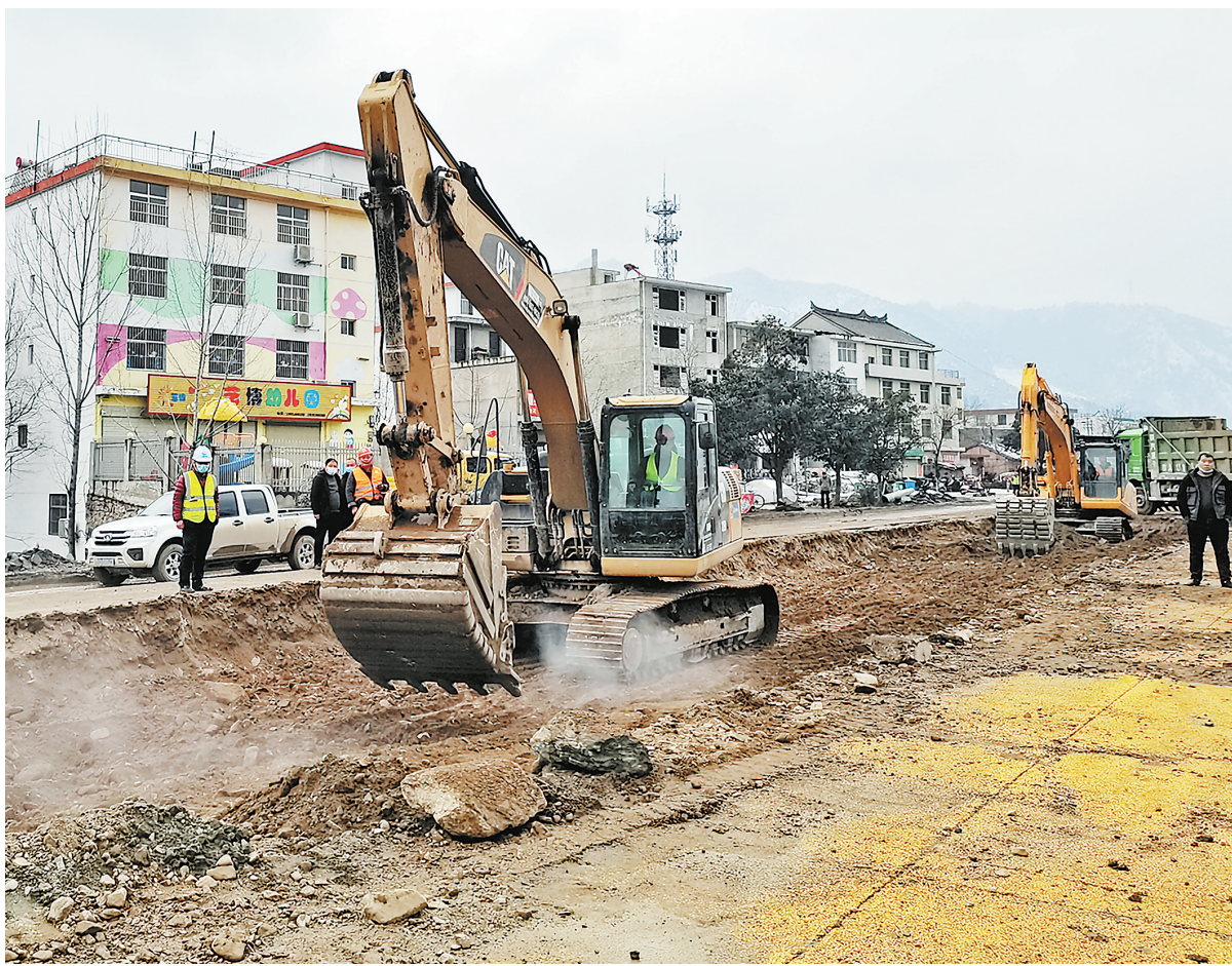
临近春节,我市各工地正在一边落实疫情防控措施,一边倒排工期,开足马力复工复产。图为1月23日,商州区西城西路项目建设现场,机器来回穿梭,工人抢抓进度,一片繁忙的建设景象。
