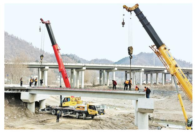
2月23日,242国道商州区板桥镇盆口铺尖角治超站南站引线桥工程现场正在实施首片20米预应力箱梁架设。 据了解,该桥全长96米、宽度10米,计划总投资400万元,项目于2021年9月开工,计划今年"五一"节前建成通车。 (刘 飞 摄)
