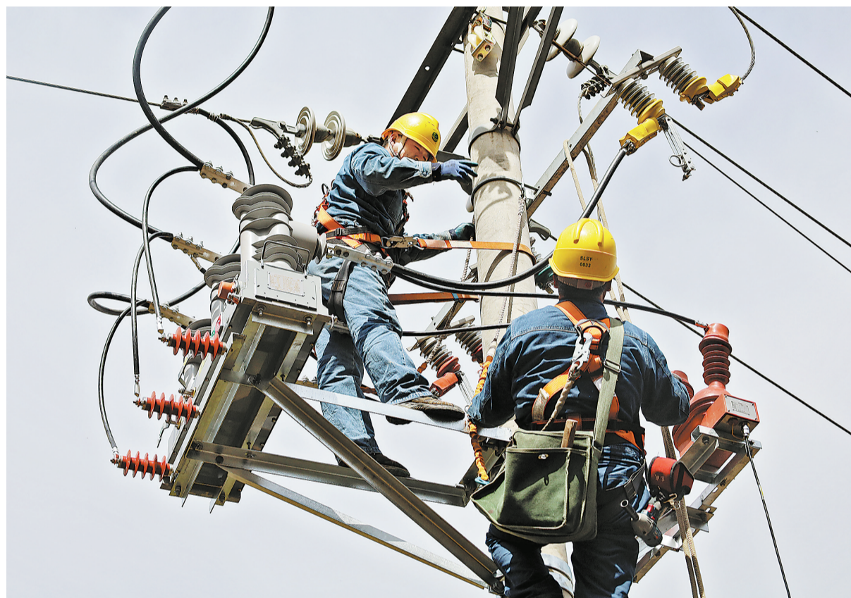
3月3日,国网山阳县供电公司通过“停一次电”“打包”实施检修、技改等多项作业,对10千伏167安门线进行综合检修,降低停电作业对客户带来的影响,提高供电可靠率。因为该公司员工在板岩镇庙台村10千伏167安门线6#杆安装开关。(陈非凡 摄)
