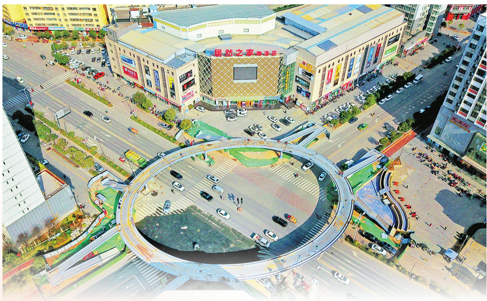
3月13日,位于商鞅大道东段的商州区第六小学人行天桥,环形主体连接点以及人行梯道安装已经完工,桥面防水、铺装、栏杆、亮化等工程正在有序施工。据了解,该人行天桥将在今年5月底建成投入使用。(记者 杨鑫 摄)
