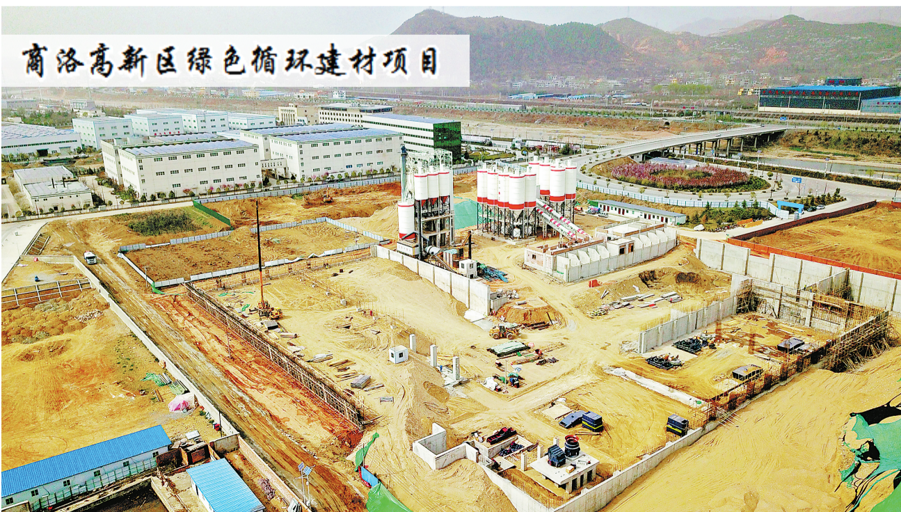
位于商洛高新区的绿色循环建材项目，总投资1.5亿元。建成后将实现“资源—产品—废物—再生资源—新产品”的循环模式，成为商洛高新区超百亿级绿色循环产业集群的重要一环。一期项目将于今年10月投产。图为3月14日记者航拍的项目建设现场。(本报记者 杨鑫 摄)
