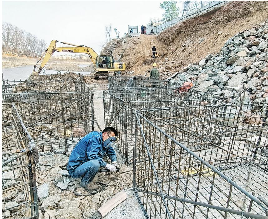
近日,丹凤县交通运输发展中心投入人力物力,对丹寺路、丹竹路去年水毁路段及路边护堤进行修复。图为工人正在对观家湾水毁路段开展施工。(本报通讯员 郑志财 摄)
