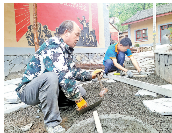
4月25日,工人在丹凤县蔡川镇留仙坪村党性教育基地项目“鄂豫陕指挥部旧址”辅步行街石板。该项目是我市唯一一个红色美丽乡村建设项目,由中组部投资400万元,丹凤县投资100万元建设,于2021年8月开工,预计今年7月1日完工。(记者 贾书章 摄)
