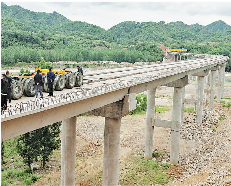
345国道改建工程项目是商南县重点建设项目之一,起于商南县富水镇桑树村顺接312国道,途经富水镇、城关街办、过风楼镇,涉及13个村,终止于过风楼镇太平庄连接过山路,全长26.4公里,按二级公路标准设计建设。路基宽10~12米,全线共设桥梁951.84延米/11座,涵洞工程87米,全段共设隧道1506延米/5座。截至4月底,该项目累计完成各类投资1.95亿元。图为正在建设中的丹江大桥16孔498延米架梁工程。(本报通讯员 代绪刚 摄)
