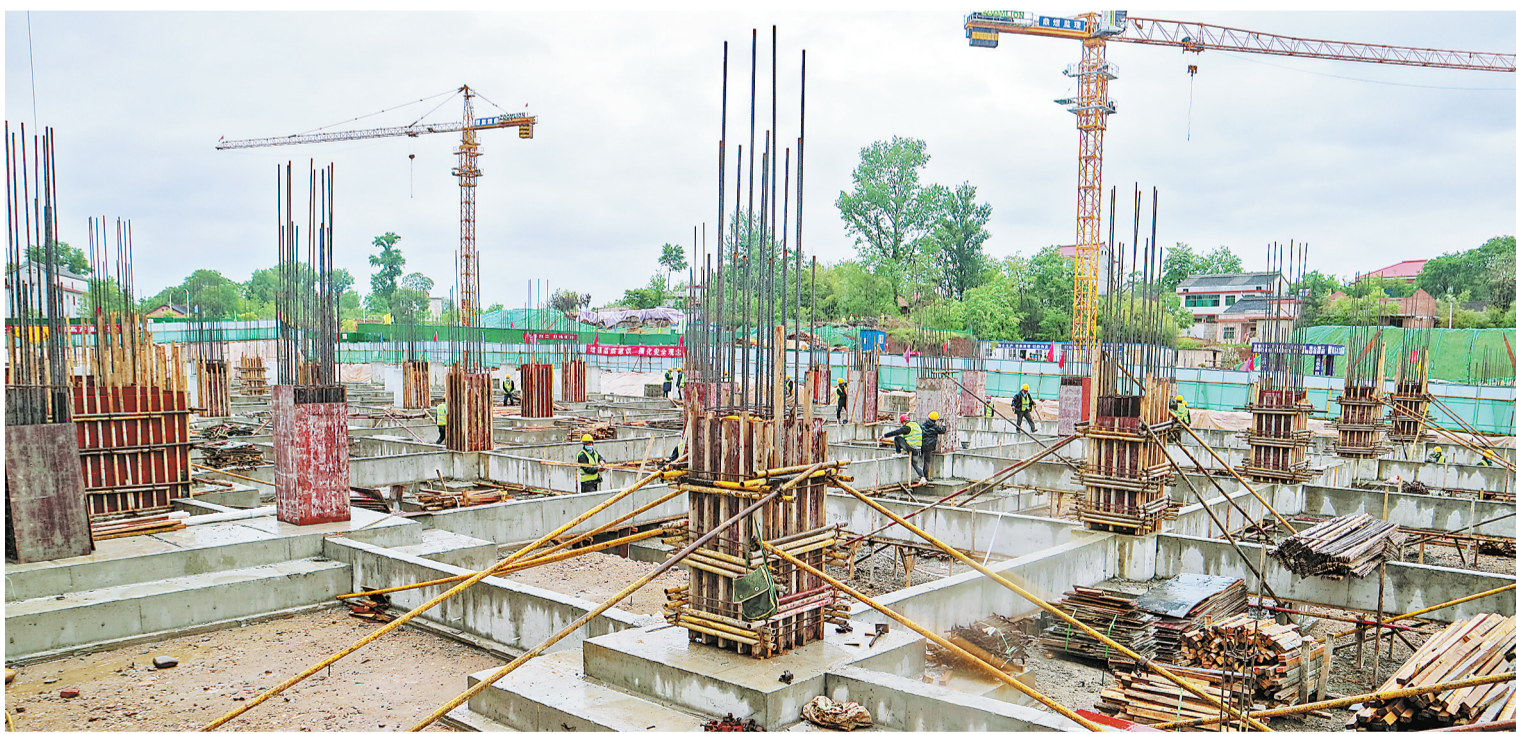
5月14日，洛南县宁洛产业园示范项目建设现场，工人们正在加紧施工。该项目占地261亩，总投资8.5亿元，建成后将为更多小微企业和中小企业提供生产经营发展平台，有利于培植园区后续发展力量，对巩固拓展脱贫攻坚成果同乡村振兴有效衔接具有重要意义。（本报记者 余婷 摄）
