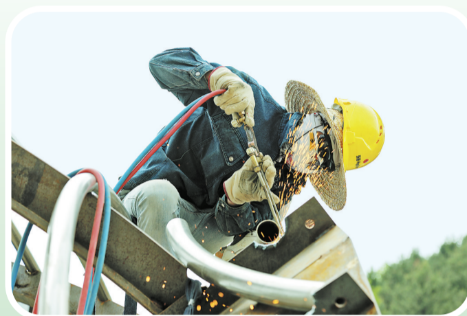
在云山湖森林康养度假区项目现场,工人顶着烈日加紧施工。
