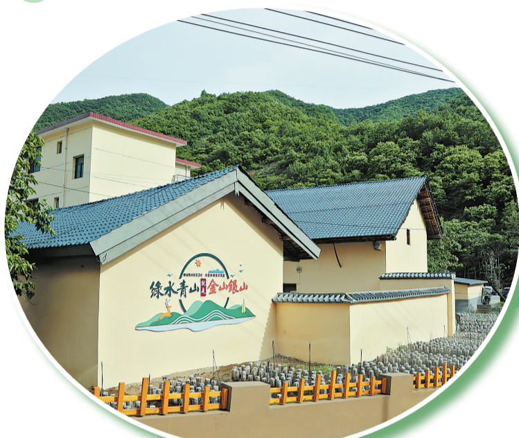
下梁镇胜利村将秦岭山水乡村建设与产业发展融为一体
