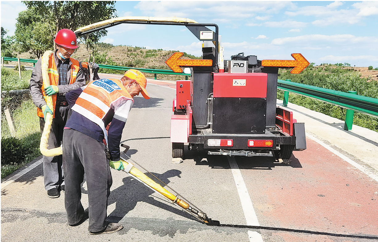
近期,丹凤县交通运输局发展中心趁着晴好天气,组织人力对管养路段路面进行集中灌缝养护,为提升路面使用寿命发挥巩固作用。(本报通讯员 王丹文 摄)
