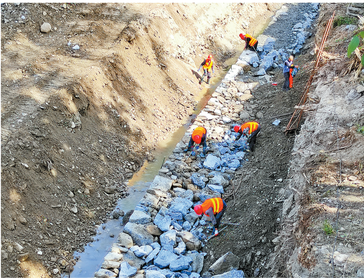
去年连续多次持续强降雨,致使山阳县法官镇法官庙村高田组300米河堤被冲毁,镇村争取资金300万元进行河堤修复。图为5月25日,工人正在修复水毁河堤,目前项目实施进度过半,计划6月上旬完工。(本报通讯员 赵倩摄)
