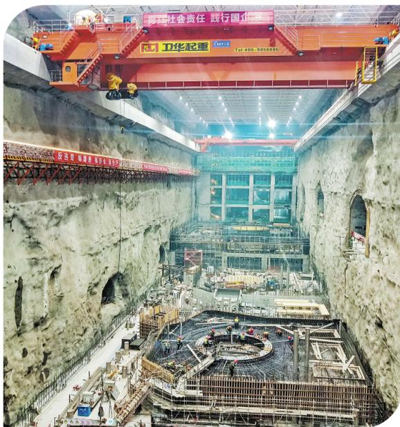
本报讯(记者 李小龙)陕西镇安抽水蓄能电站位于镇安县月河镇,是国家电网公司服务革命老区振兴发展、推进能源结构调整和西部大开发战略实施的重大工程,也是我国西北地区首个开工建设的抽蓄电站工程。该工程主体于2019年6月开工,截至今年5月底,电站项目累计投资45.52亿元,总工程量完成约65%。公司营地、上下库连接路、35千伏施工变电站、砂石拌和系统等工程已建成投用,电站上水库开挖填筑、地下厂房机组设备安装、下水库大坝填筑等工程正在顺利推进。
