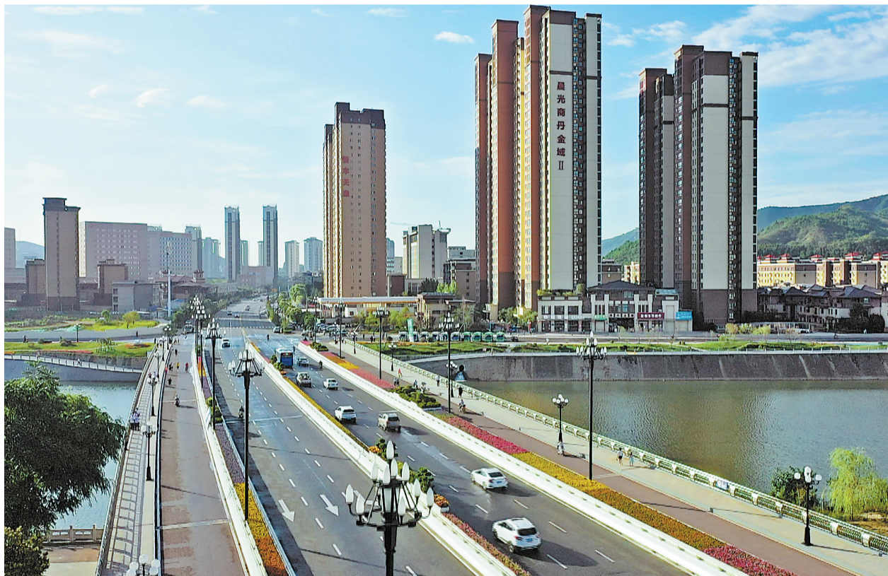
作为与民生密切相关的基础设施，今年，我市在中心城市建设中，对商鞅大道南秦大桥进行了“八拆八提升”，形成了简洁明快、美丽大方的景观效果，提升了桥梁的交通安全和品质品位。图为近日拍摄的改造提升后的商鞅大道南秦大桥。（本报记者 李小龙 摄）
