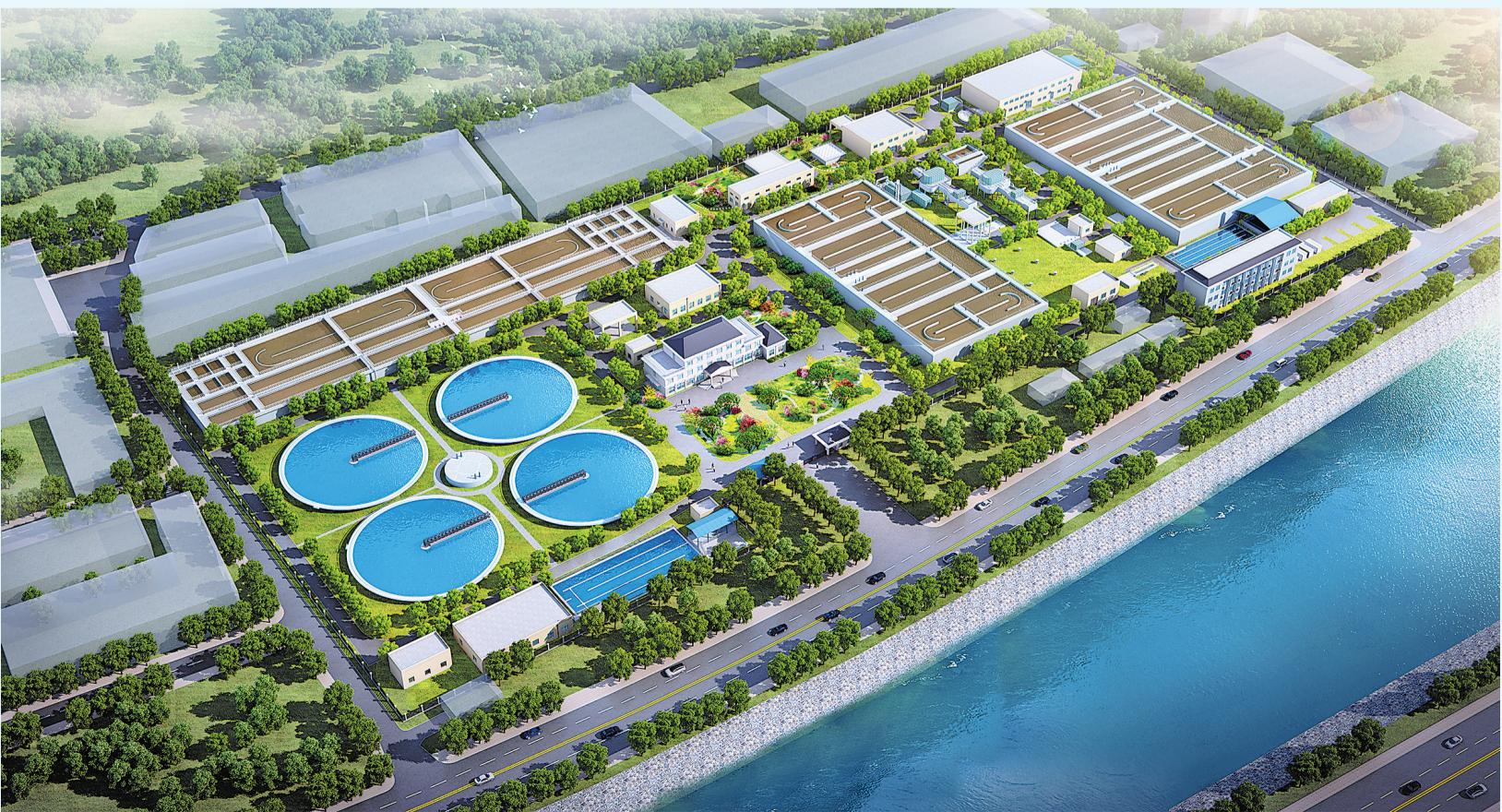
污水处理厂项目
