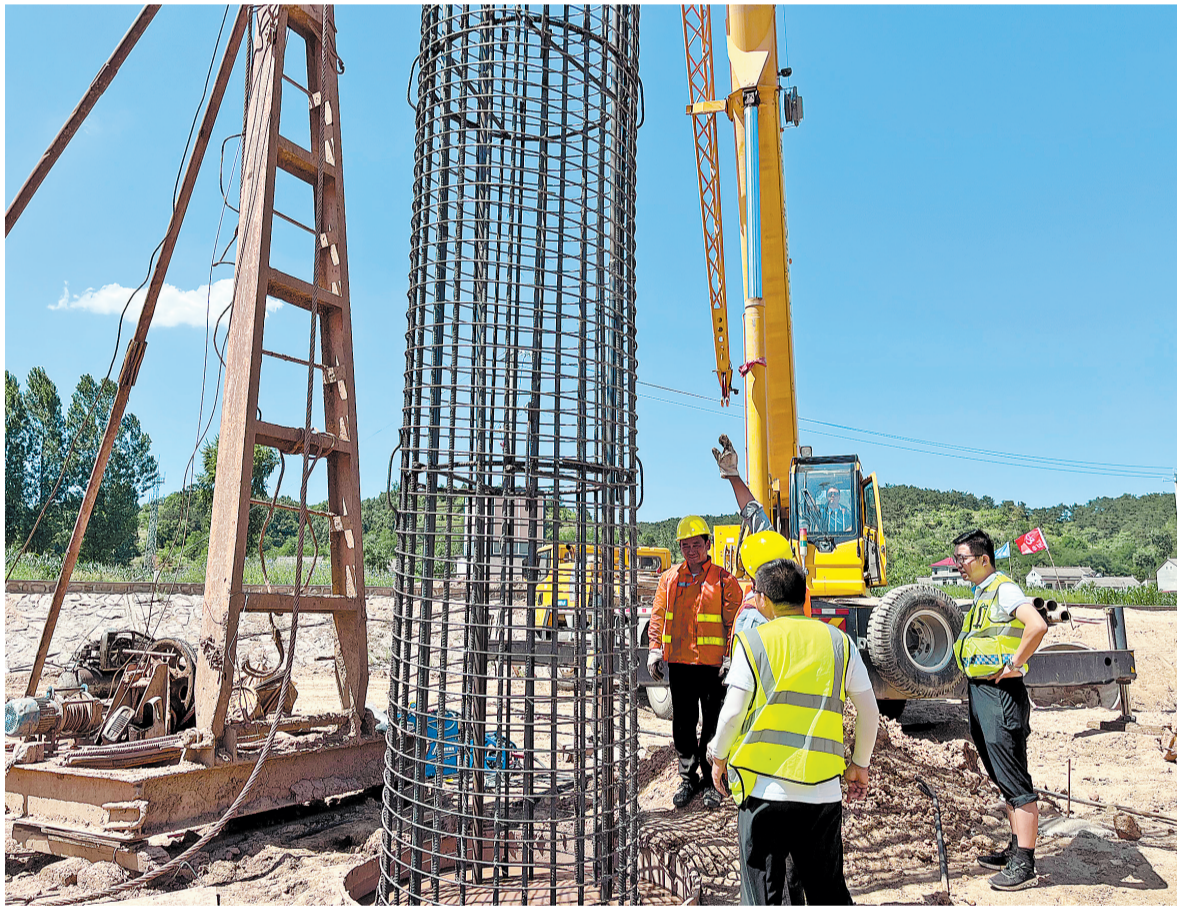
6月22日,洛南古城镇沙河大桥工程首根桩基顺利完成水下混凝土灌注,为桥梁施工奠定了坚实基础。该工程由市公路局沥青拌合厂承建,预计7月20日完工。(本报通讯员 杜妍 摄)
