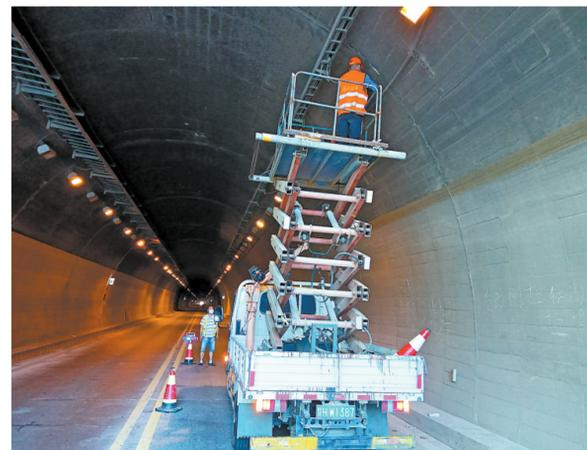
近日，商州公路段投入资金对312国道麻街岭隧道照明设施进行全面排查检修，对故障灯具进行更换维护。本次共完成85套照明设施维保，提高了公路隧道照明质量，有效保障了过往车辆通行的安全性和舒适性。（本报通讯员 刘国强 摄）
