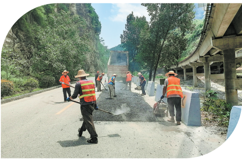
8月8日，市公路局镇安公路管理段组织养护队伍，对G211国道辖养路段坑槽、沉陷等公路病害开展集中修补，有效提升了路况及路容路貌，保障了辖养公路的安全畅通。（本报通讯员 潘妮 摄）
