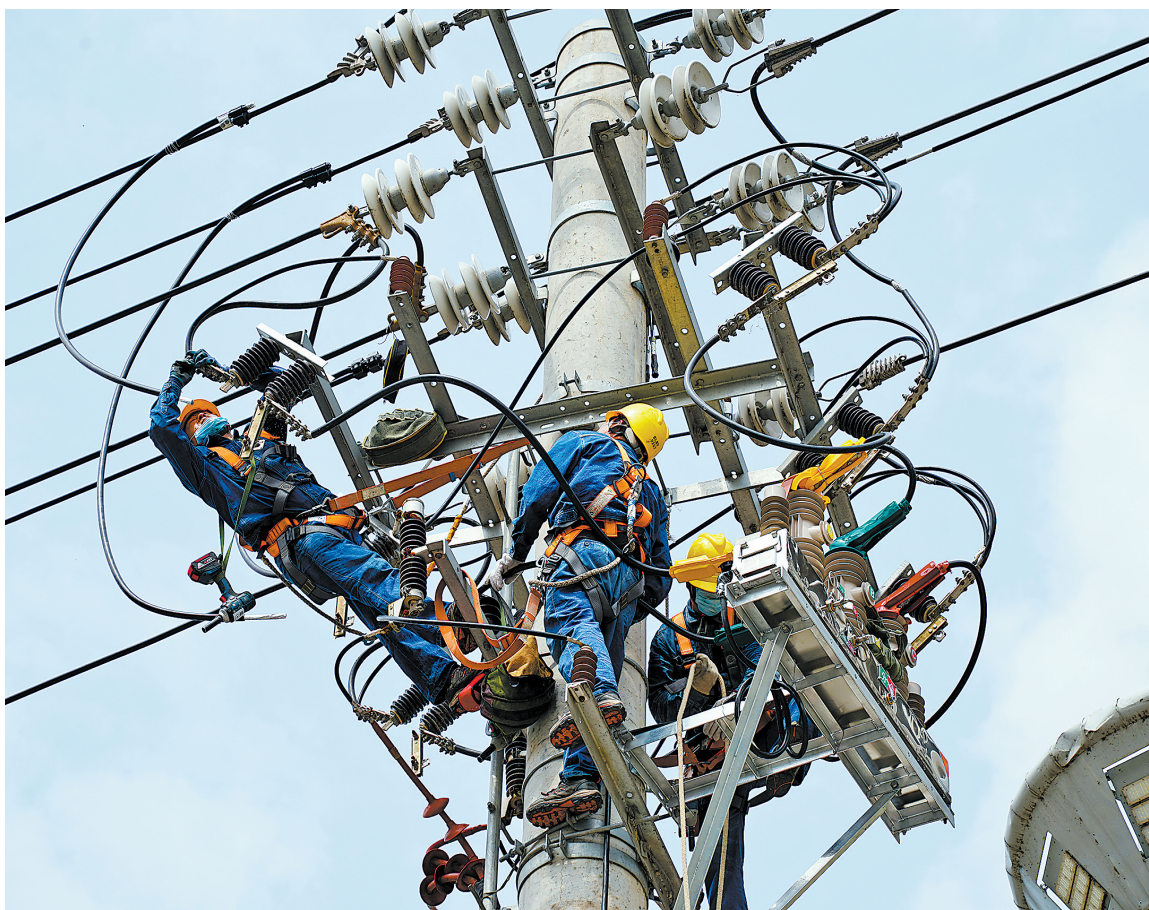
9月15日,国网山阳县供电公司抽调基层供电所40多人,对10千伏136市区Ⅲ线进行综合检修。整个检修过程零违章,提高了配网线路运行的安全性、可靠性。(本报通讯员 王森 摄)
