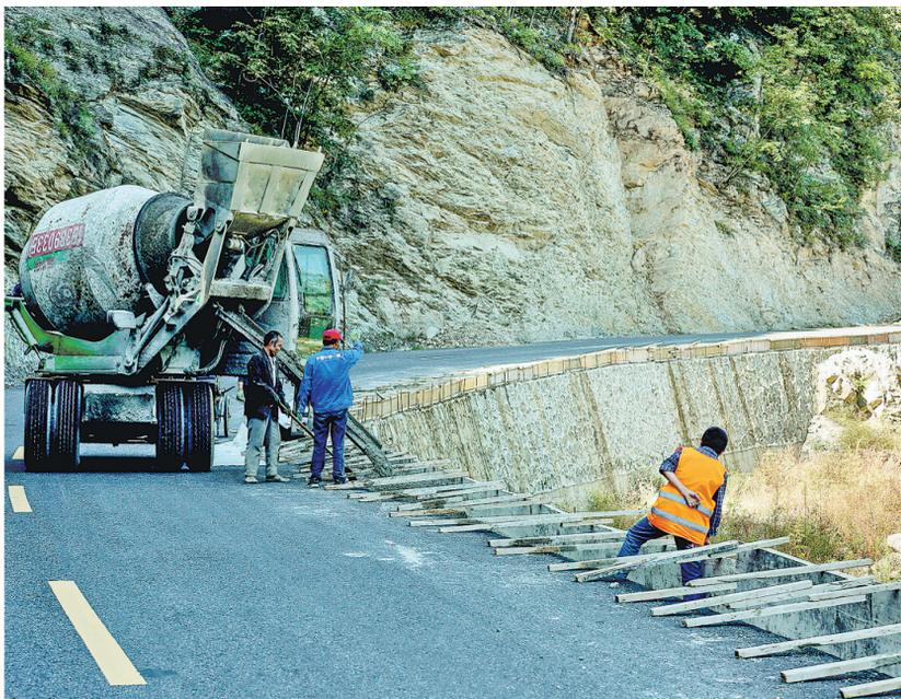
商州区三岔河镇在做好疫情防控的同时,加快陕西省乡村振兴示范镇建设,加班加点提升建设进度。图为9月26日,施工工人正在对柏油路边缘进行水泥浇筑。(本报记者 王孝竹 摄)
