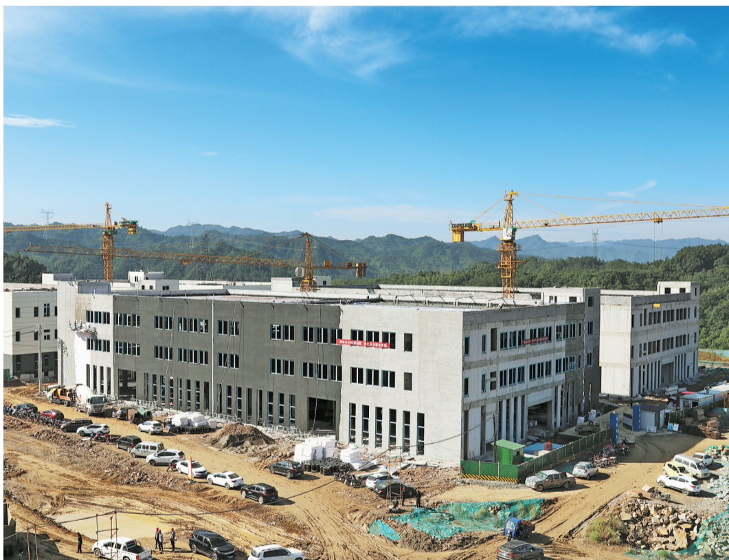
今年以来，商南县按照“筑巢引凤”“引凤筑巢”模式和经营工业地产理念，计划用3年时间投资12亿元，在“双创”产业园建成30万平方米标准化厂房。目前，一期8栋8万平方米厂房主体工程已基本建成，正在进行内部装修和外墙板安装及屋顶施工，计划9月底全部投入使用。（本报通讯员 代绪刚 摄）
