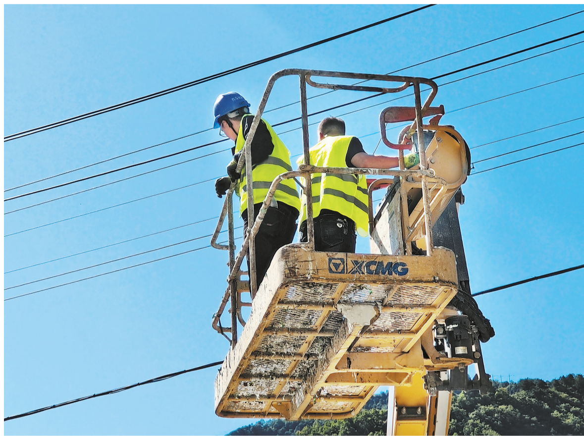
为了提升城市品位,梓水县实施网络“三线”改造入地工程,对城区主街道、小区巷道空中的移动、电信、广电“三线”进行改造,让空中“蜘蛛网”入地,扮靓城市容颜,受到市民点赞。图为9月29日县城迎春广场施工现场。
