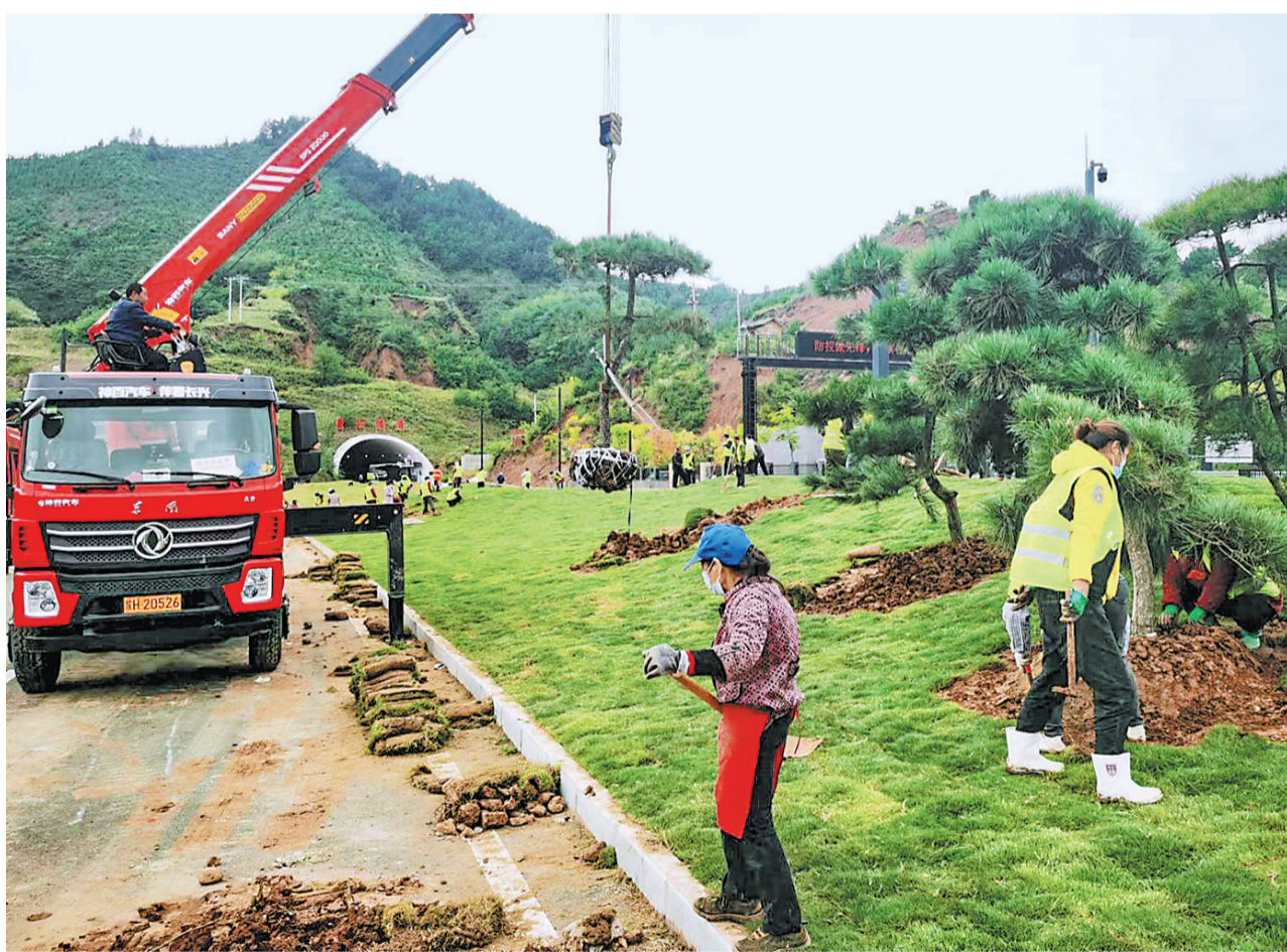
10月8日，在中心城区环城西路施工现场，工人正在完善绿化带景观树移栽和隧道美化，全力保障如期通车。据了解，环城西路道路全长4050米，建设内容包括环西路及马莲塔道路、新建商中北大门广场、丹南片区重点项目坟墓安置点、构峪河道治理、构峪口袋公园工程5个配套项目，项目实施将打通城市环线，连接242与312国道，便捷城市南北交通，推动西片区经济社会发展，是“打造山水园林城市，建设旅游康养之都”重要支撑。 (本报记者 王孝竹 摄)
