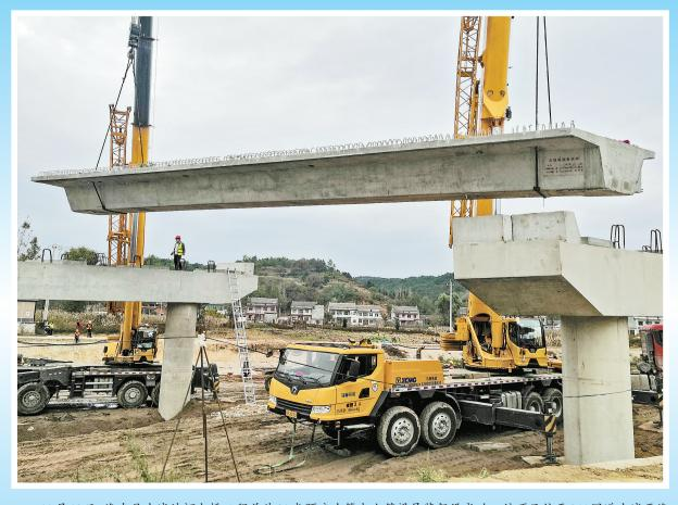
10月13日,洛南县古城沙河大桥工程首片20米预应力简支小箱梁吊装架设成功。该项目位于344国道古城至洛 南县城改建路段,全长106.08米,宽12米,设计速度60km/h,由市公路局沥青拌合厂承建,于今年6月开工,计划12月 底前建成通车。 (本报通讯员 杜 妍 摄)
