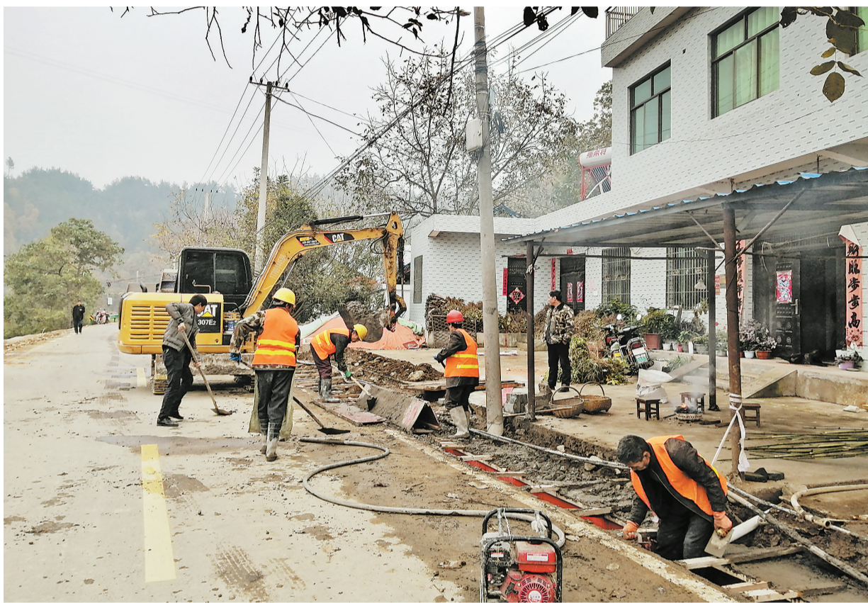
连日来,商南县清油河镇团坪村利用穿过该村的清渠路“白改黑”机会,对人口居住集中的姚家湾进行环境整治,改造厕所,修建排水沟、绿化带,完工后,该段将焕然一新。(本报通讯员 李治军 摄)
