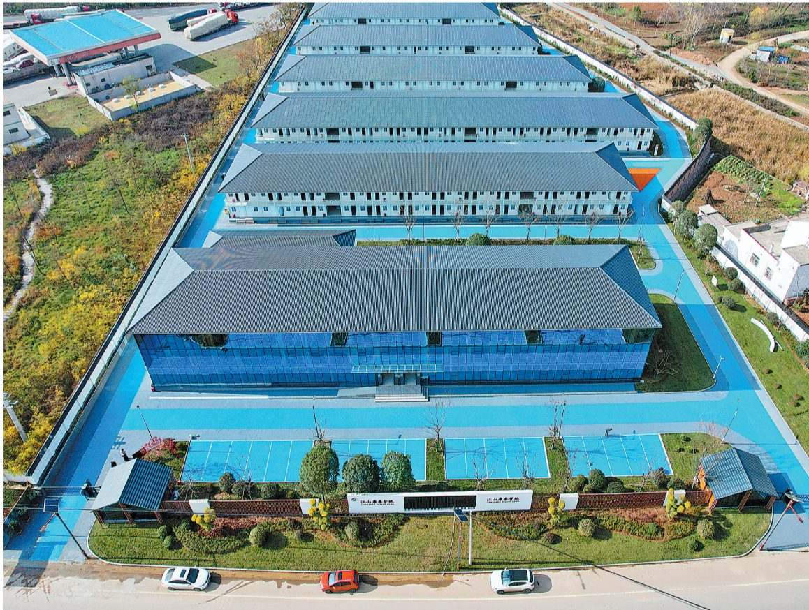
近日，位于商州区腰子镇的江山康养营地项目竣工。该项目投资约3000万元，占地面积1.97万平方米，按照功能多样、效益最大化的理念，平时可作为景区配套的民宿，为游客提供优质的住宿服务，特殊时期，可作为应急保障用房，实现了“一房多用”。（本报记者 杨鑫 摄）
