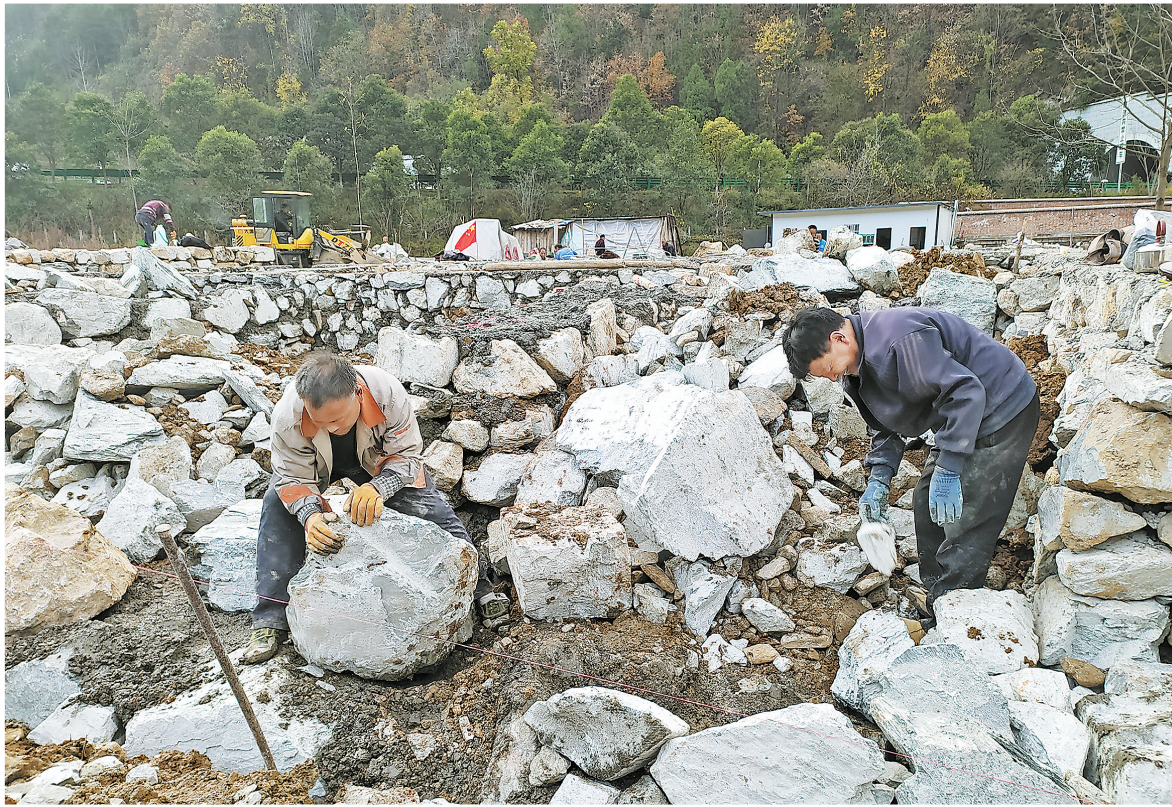
近日，工人在山阳县高坝店镇鹤岭沟村丹宁高速公路拆迁安置房建设现场砌砌房基。该安置点计划安置丹宁高速公路拆迁户10多户，工程在紧锣密鼓进行中，让拆迁群众早日住上新房子，安居乐业。（本报记者 贾书章 摄）
