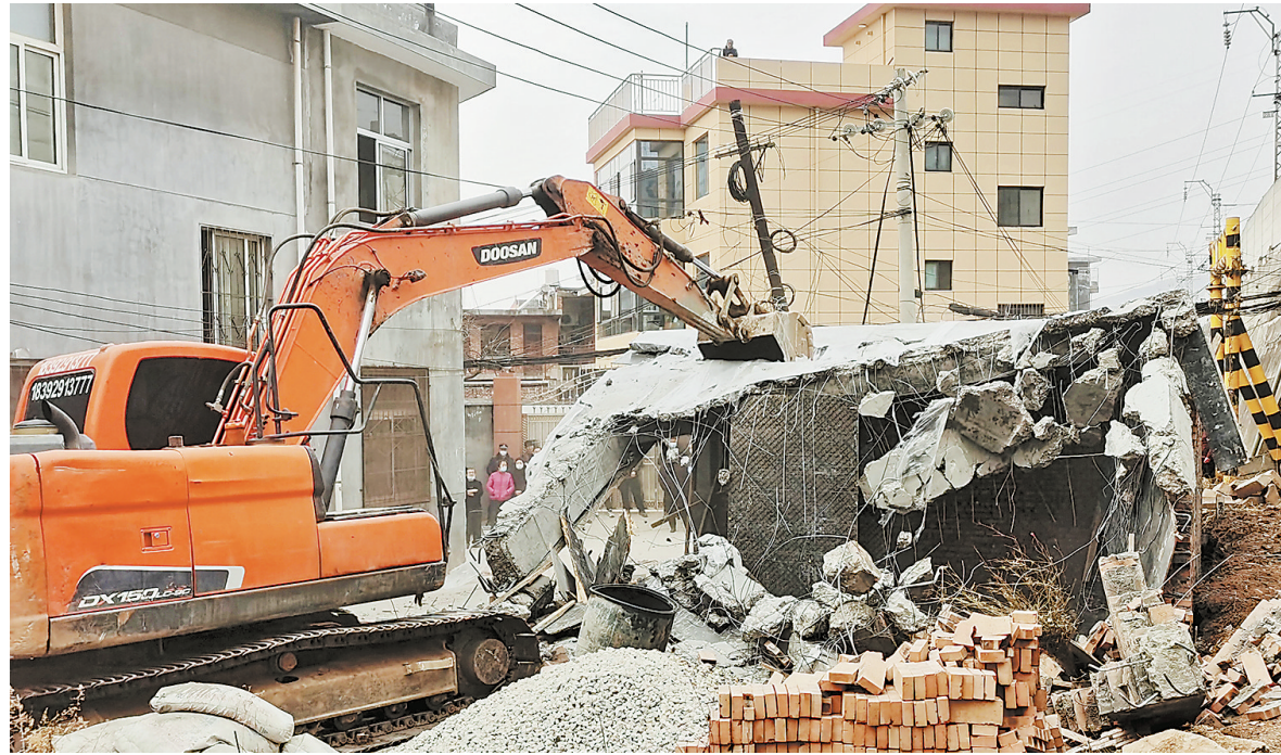
1月11日,丹凤县自然资源局联合县城管局、市场监管局等组织执法人员80多人,出动挖掘机、推土机、装卸车20多台,依法对城区凤麓、河洞、丹江等社区7处违法建筑物进行强制拆除。这是丹凤县2023年“城镇建设管理提效年”打响的首场拆违战役,起到了“拆除一处、震慑一片、教育一方”的作用。(本报通讯员 冯旭红 摄)
