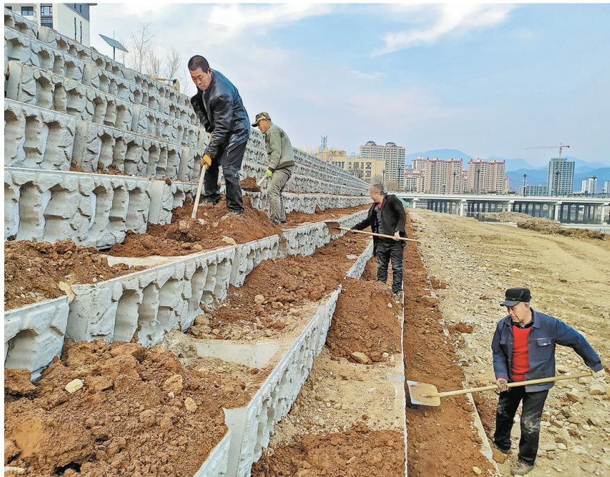
2月5日,在商州区南秦河口北岸,施工人员正在为生态框格内垫土。据悉,该段新修河堤长850米,从去年秋季开始施工,市水利部门采用生态堤防工程措施,使用预制的生态框格堤坝,在框格内种植根系发达的护堤草,改变过去水泥浆砌河堤的单一面貌,收到既可以防洪又有绿化景观的效果。(本报记者 贾书章 摄)
