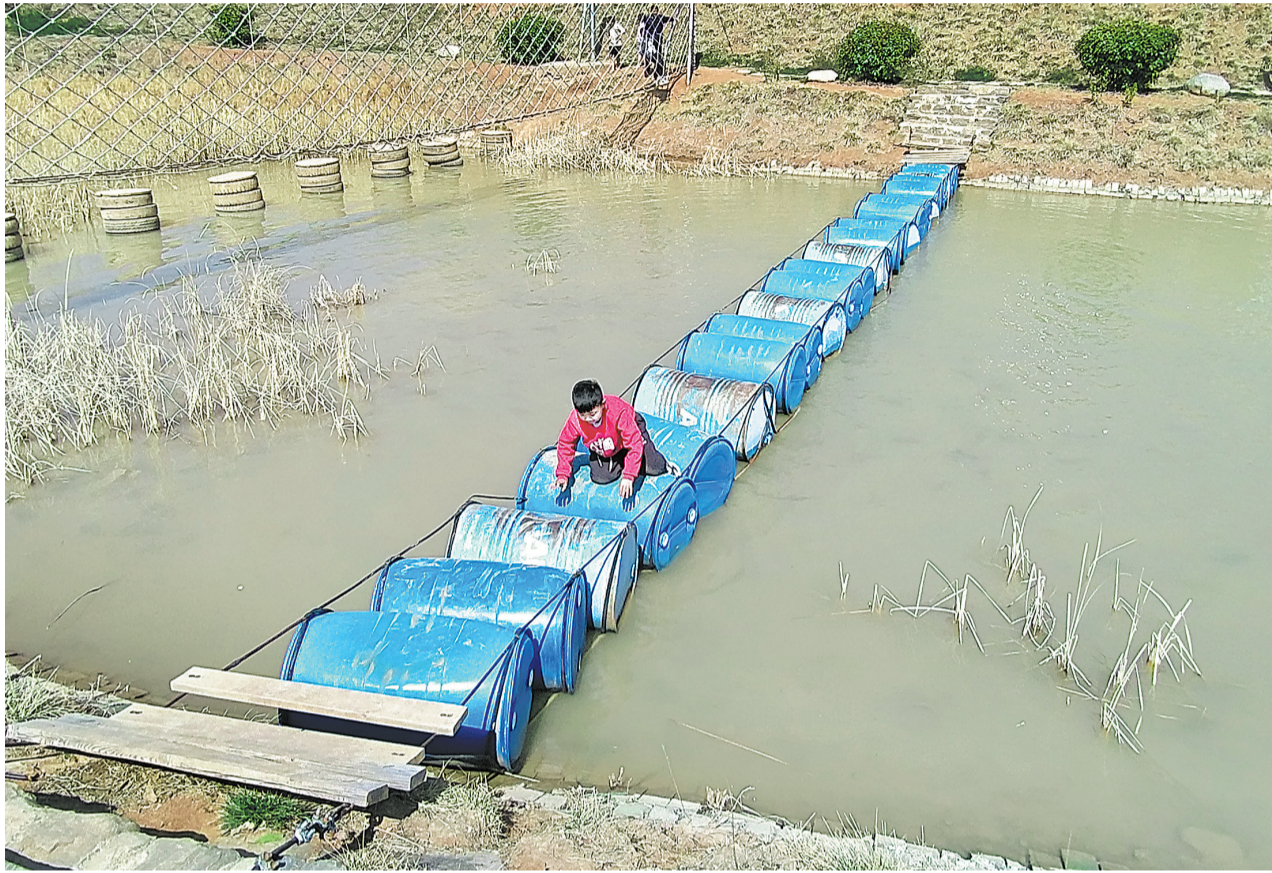
3月5日,孩子们在丹凤县棘花镇核桃主题公园一小型水上乐园体验吊绳攀跳过河。据记者观察,该乐园久未检修,钢丝绳已部分老化,空油桶铺设的水上浮桥一根钢丝绳已经崩断(孩子右手侧),存在安全隐患。随着春日天气逐渐变暖,游客渐渐增多,建议相关部门做好对娱乐设施的检修维护,让游客乘兴而来、安全而归。
