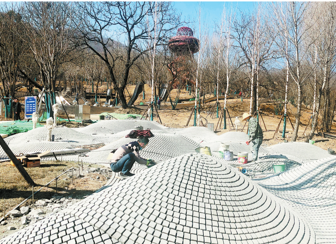
日前,位于柞水县营盘镇的云山湖康养产业园项目正在加紧施工。该项目总投资85亿元,规划建设生态旅游、健康运动、森林康养等六大产业集群,打造“好山好水好空气、养性养神养身心”森林康养品牌,累计完成投资25.13亿元,预计2028年全部建成。(本报记者 余 婷 摄)
