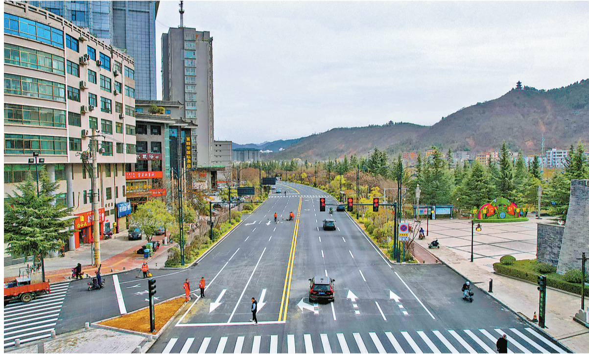
中心城区江滨大道提升改造工程历时50天,于3月19日顺利完工。该路段以崭新的沥青路面、清晰的标志标线、舒适的行车环境为市民出行提供安全、快捷、舒适的通行体验。(本报通讯员 杜 妍 摄)
