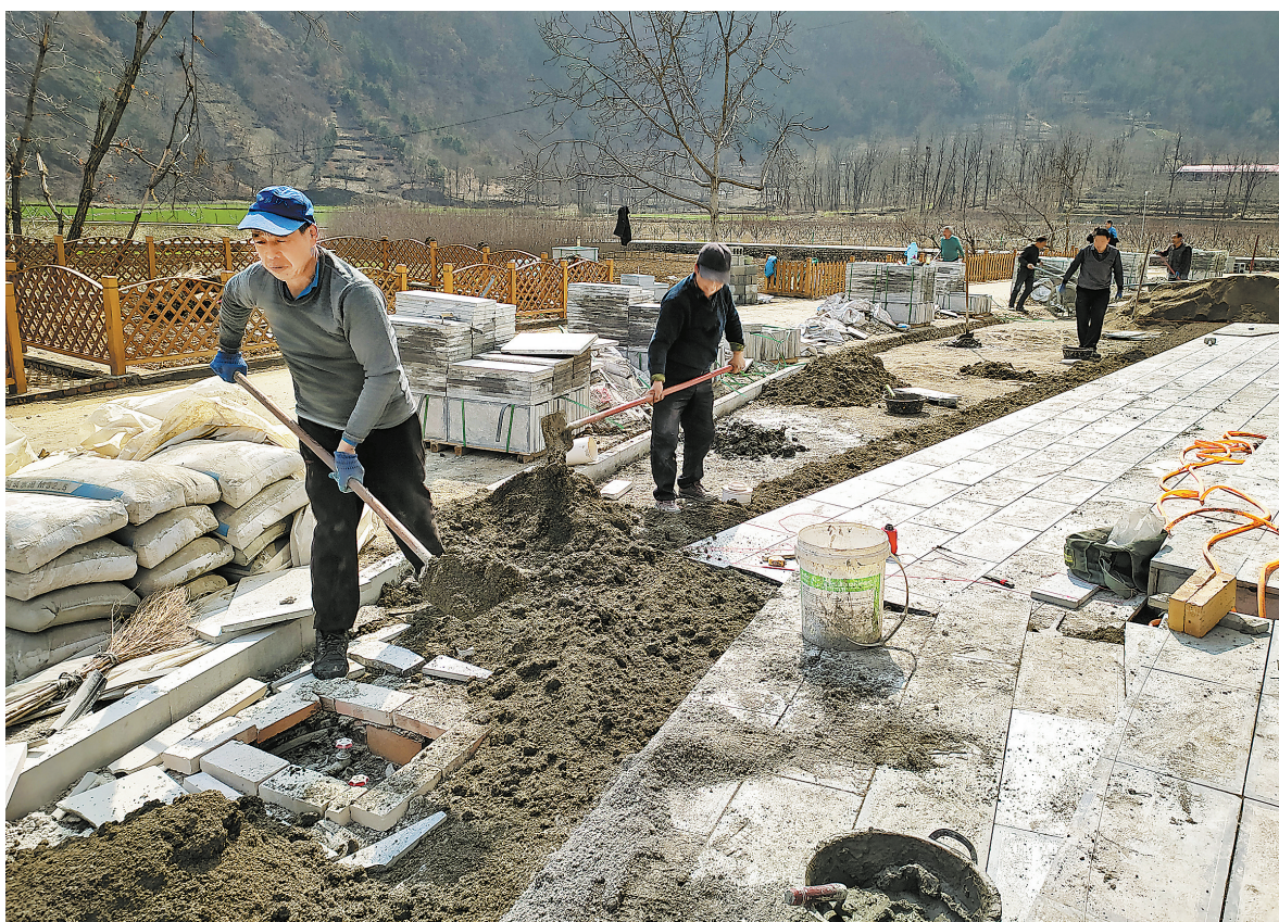
3月20日,山阳县色河铺镇陆家湾村群众在为自家场院铺地。该镇加快实施美丽乡村建设,投入资金为群众提供建筑材料,督促群众按要施工,确保每户场院整洁干净。(本报记者 贾书章 摄)
