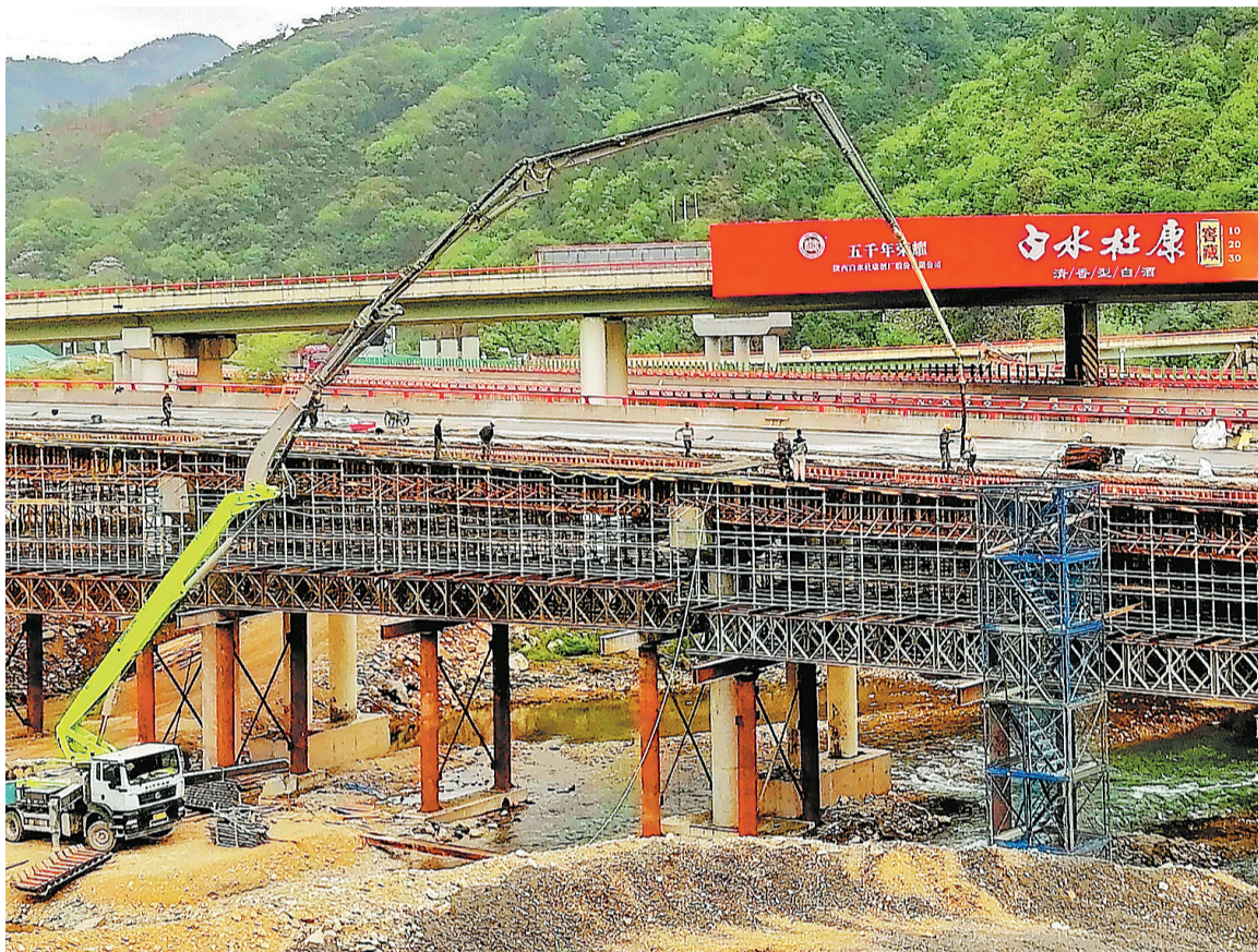
4月18日,全市重点建设项目丹(凤)宁(陕)高速公路竹林关立交枢纽工程正在抓紧施工。(本报通讯员 彭涛 摄)
