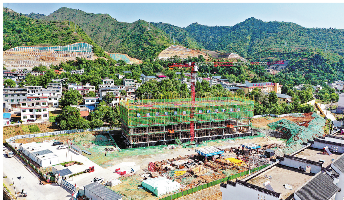
近日，在丹凤县区域医疗卫生次中心项目建设现场，机械臂挥舞，工程车来往穿梭，各项施工正有条不紊地进行。该项目位于丹凤县竹林关镇，建设面积1.1万平方米，总投资1.3亿元，预计今年年底竣工，建成后辐射竹林关、土门、寺坪、花瓶子4个镇及商南县、山阳县毗邻区域，覆盖辖区人口约7.5万人，可满足辖区群众的就医、康复、中医保健等基本医疗服务。（本报通讯员 杜文龙 摄）
