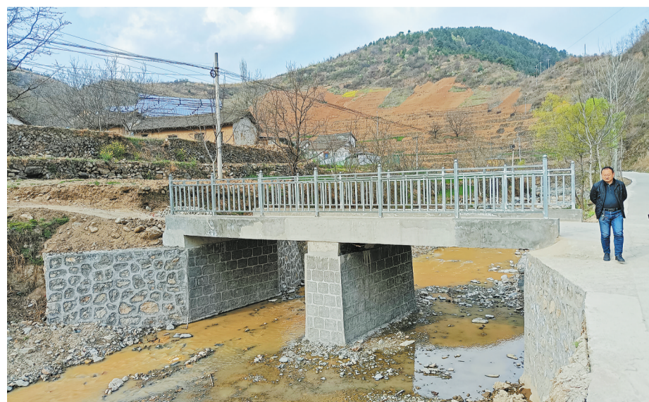
中国邮政集团捐资修建的杨斜镇砚池河村十一组便民桥
