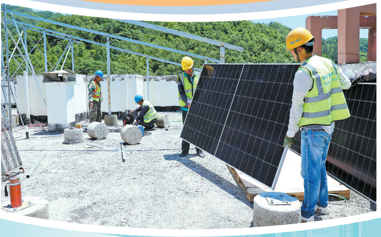
工人在安装光伏板
