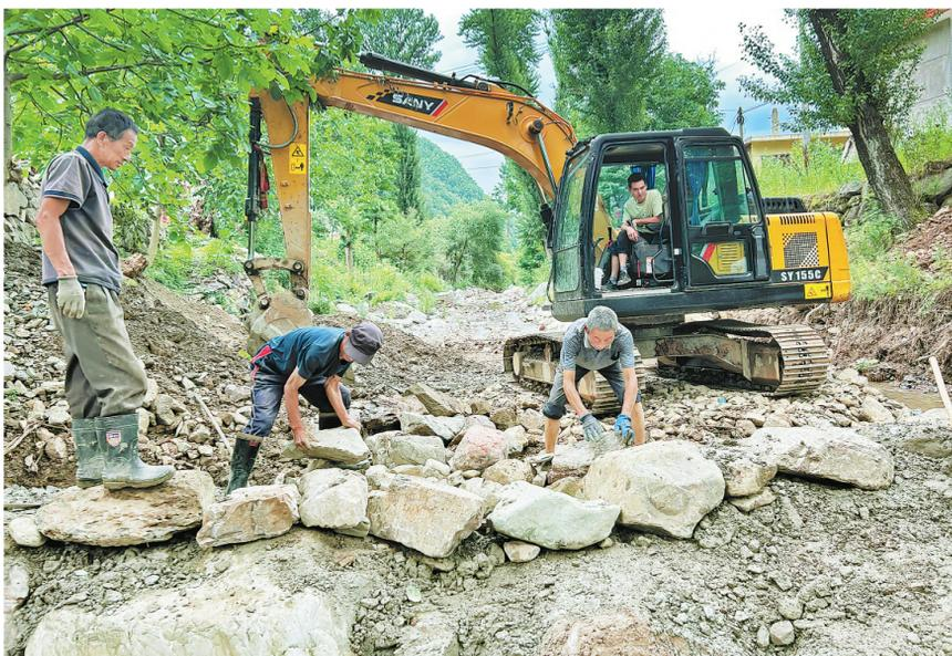
7月1日，洛南县麻坪镇云蒙山村抢抓汛前窗口期，拿出村集体经济收益1万多元，在头岔河修建三处拦沙坝，起到保护桥基及两岸河堤基底的作用。（本报记者 肖云 摄）
