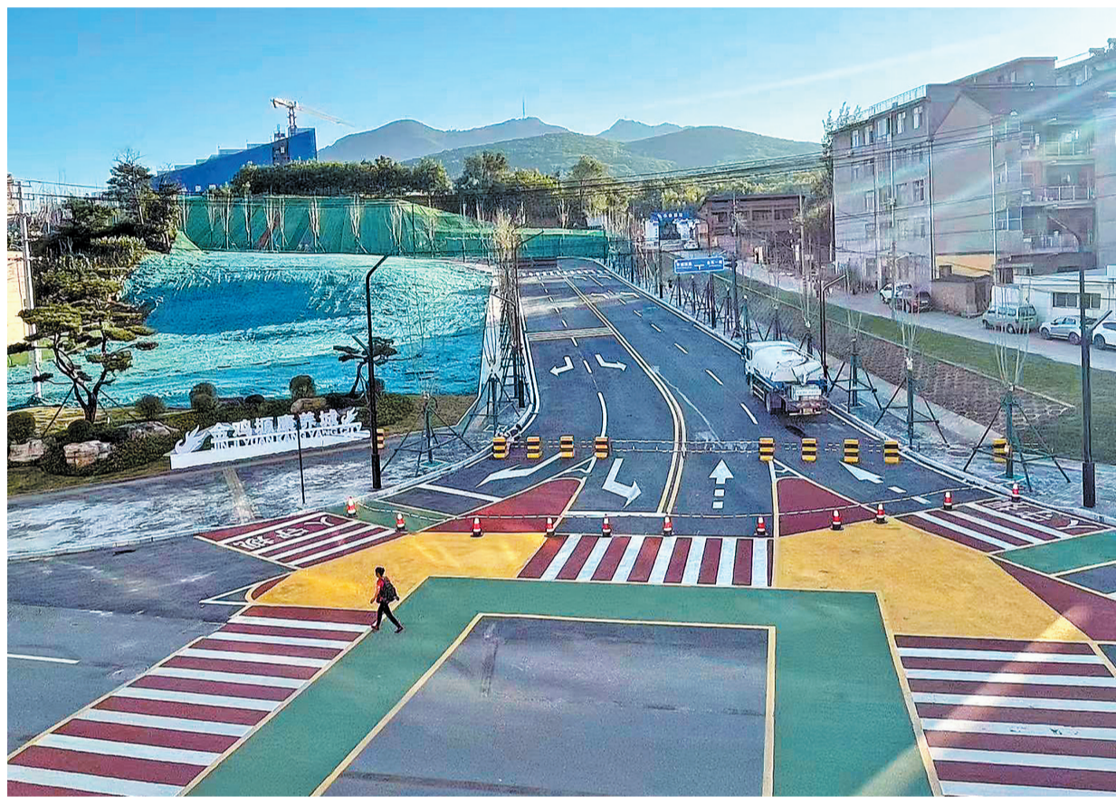
7月10日,商洛市文博路市政建设工程竣工。该工程位于市区西段,全长870米,是商洛市金鸡堰康养项目的配套工程,其中与北新街交汇处的90米由商洛公路局机械站承建,商洛公路局机械站倒排工期,压茬推进,从6月29日晚开始施工,仅用短短10天时间就高质量完成了管涵铺设、路基开挖、换填、面层摊铺以及人行道两侧边坡修整,种植草皮和景观树等全部工程任务。
