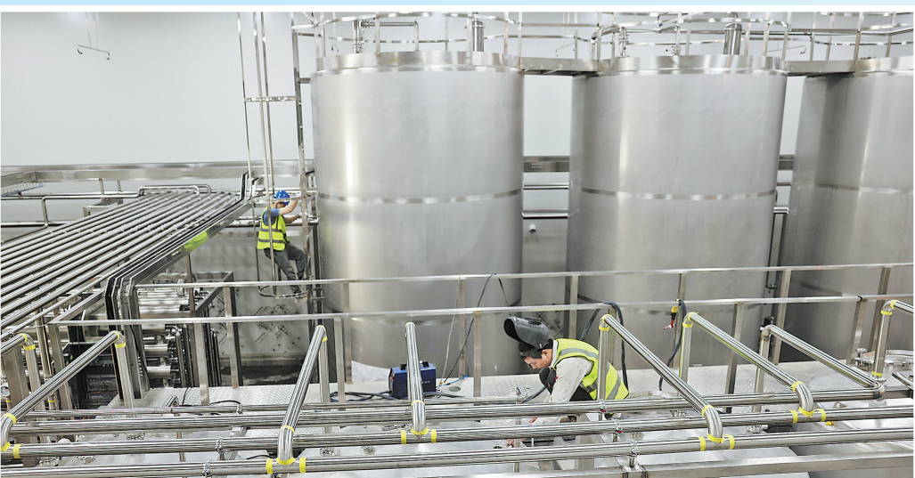
近日,商洛国蜂蜜水产业园内,工人正在安装净水设备。该项目建成后预计年产鲜存双峰蜂蜜水4万多瓶、桶装水1200万桶、瓶装水1.4万瓶,带动就业500多人。(本报记者 李敏 摄)
